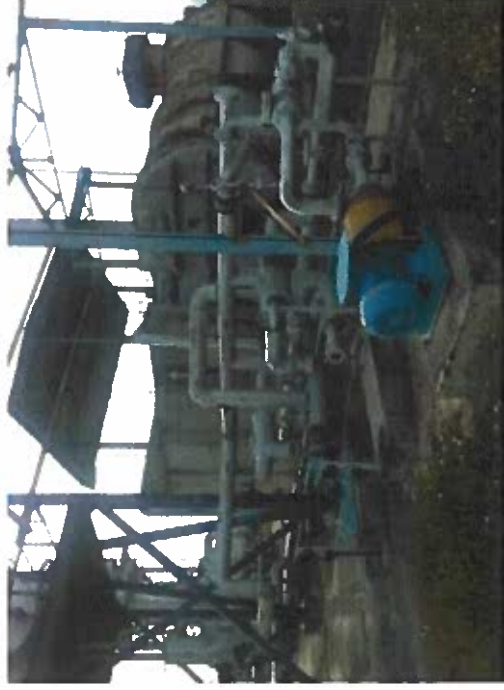
Calentador de Aceite Térmico
